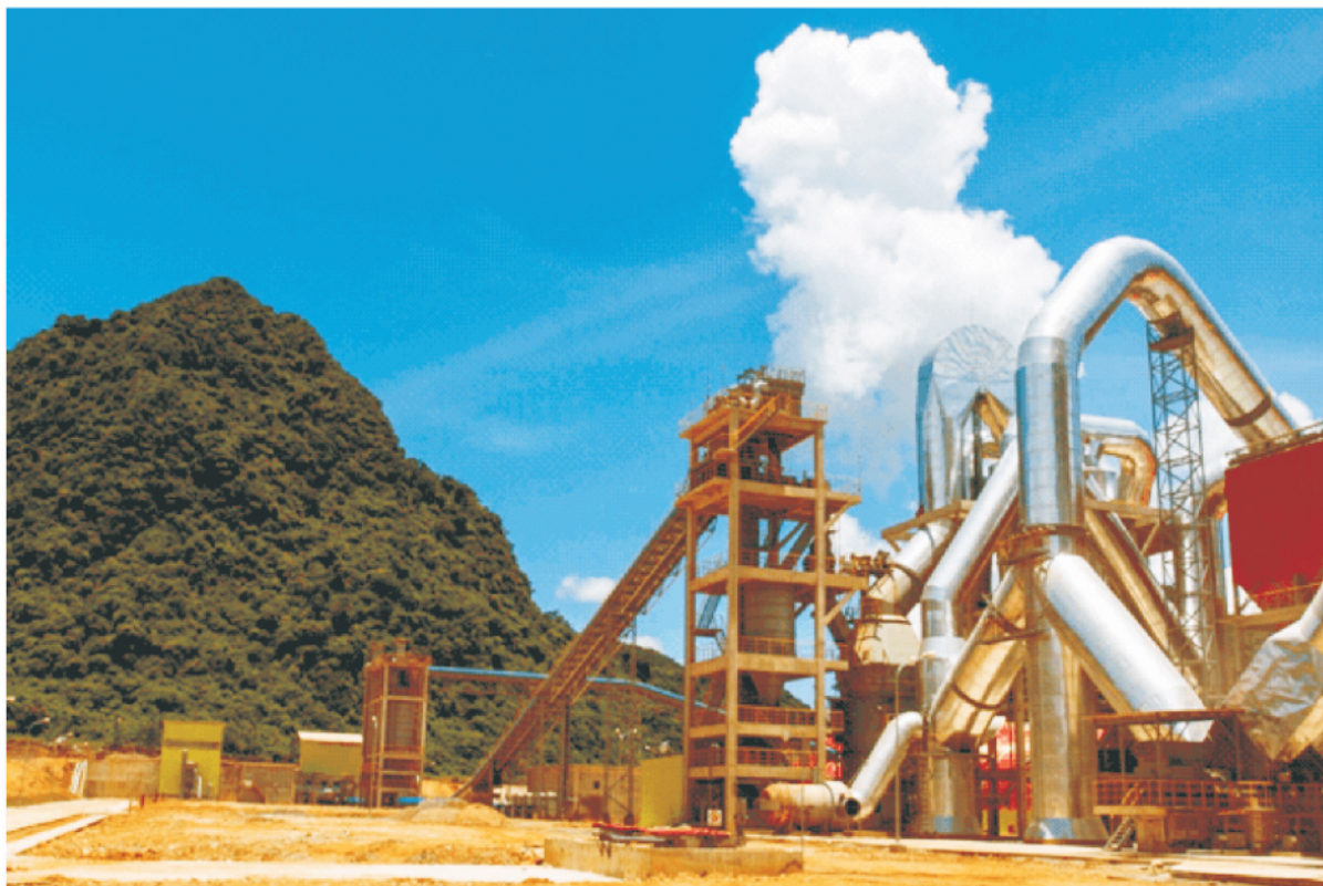
Nhà máy Xi măng Văn Hóa, công suất 1,6 triệu tấn clinker/năm đưa vào hoạt động năm 2013
