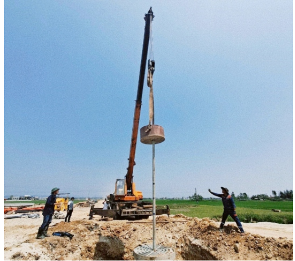
Trung tâm Kỹ thuật Tiêu chuẩn Đo lường Chất lượng thí nghiệm cọc bằng phương pháp biến dạng lớn PDA
