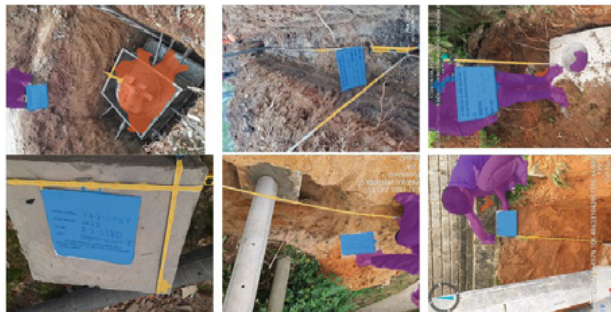
Hình 2: Một số hình tự rà quét và phát hiện đối tượng trong công tác thi công đầu tư xây dựng các công trình lưới điện
